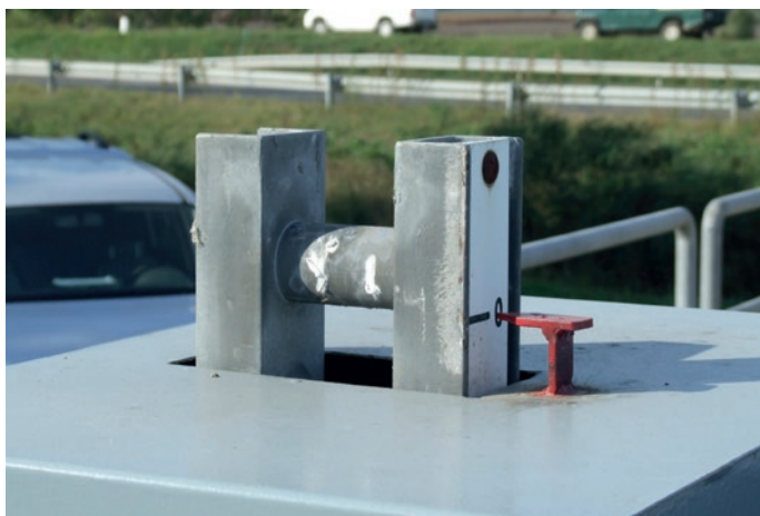
Pólyafoki-zsilip, mentett oldali zsilipállás jelző
