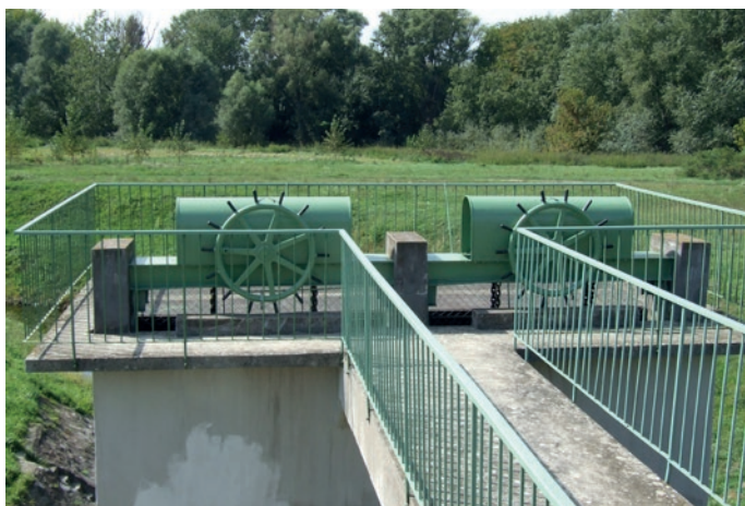
Foktői-zsilip, hullámtér oldali kezelőakna
