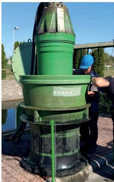
Az 1. számú szivattyú felülvizsgálata
