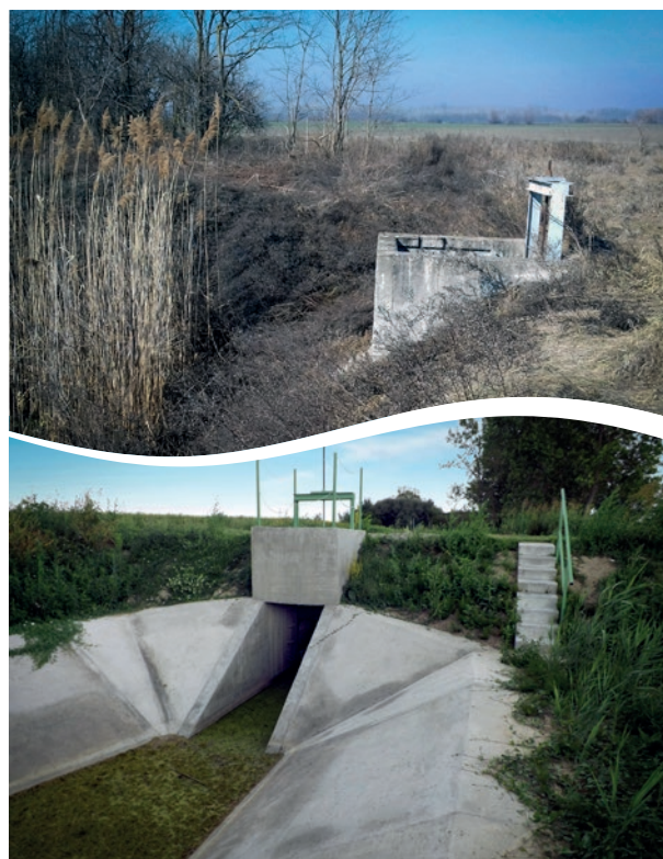
A Karapancsai-főcsatorna 19+218 cskm szelvényében lévő zsilip a felújítás előtt és után
