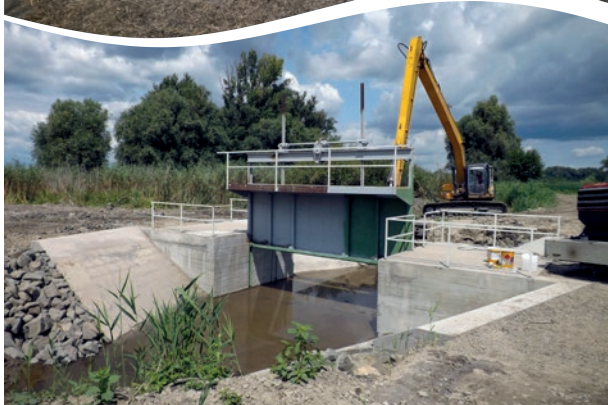
A Karapancsai-főcsatorna 10+030 cskm szelvényében lévő zsilip a felújítás előtt és a felújítás közben
