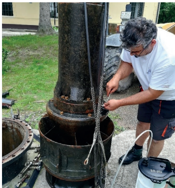
Hercegszántói szivattyútelep - ABS VUPX0501 búvárszivattyú javítása
