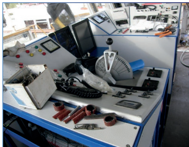
JÉGTÖRŐ VII. új kormányállás és vezérlőpult építése
