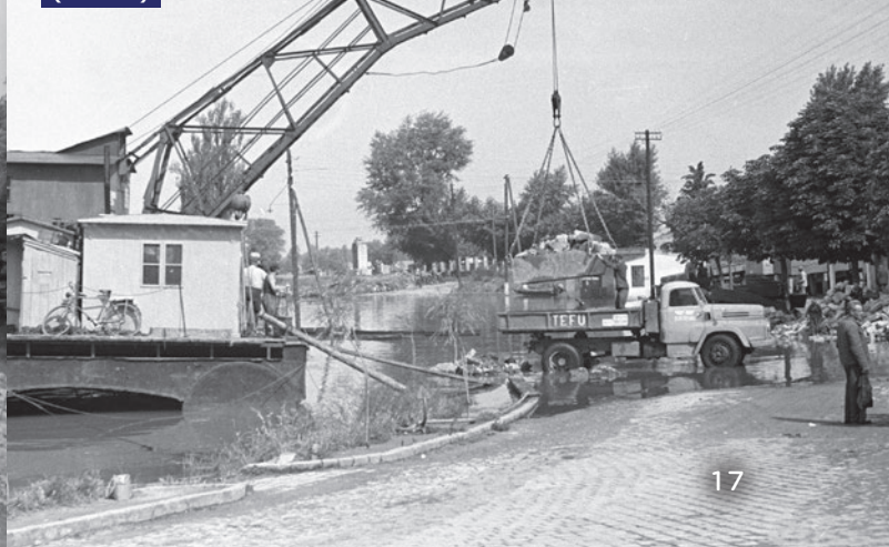
Úszó gőzdaru kőrakodás közben (1965)
