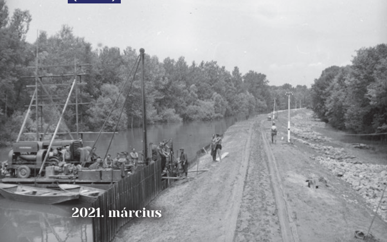
Védelmi osztag szádfal verés közben (1965)
