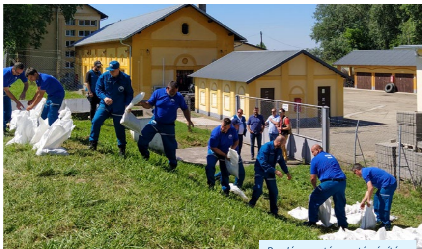
Bordás megtámasztás építése
